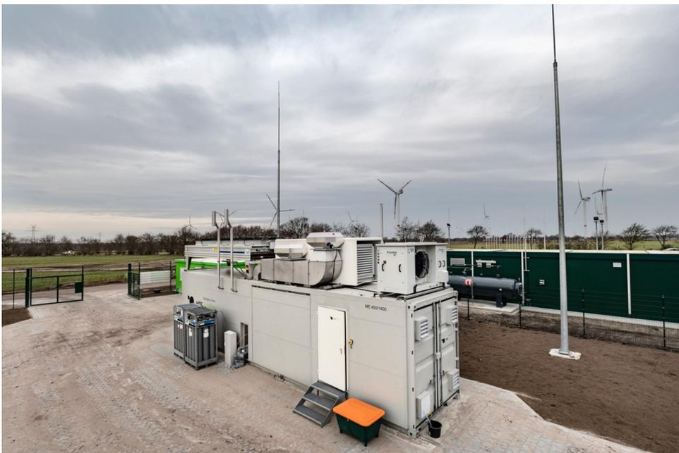
Abbildung 1: Im Vordergrund: Container des Elektrolyseurs; im Hintergrund: Wasserstoffeinspeiseanlage
